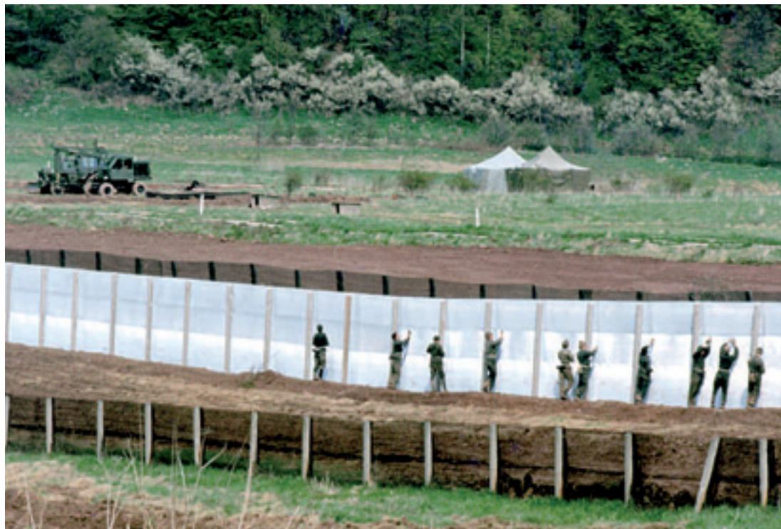
Montage des Streckmetallgrenzzauns
